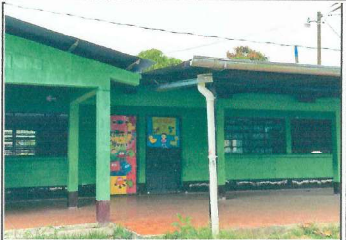
Foto 2: REPARACIÓN Y MANTENIMIENTO DE LOSA DE PATIO
